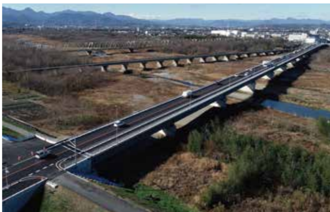
神流川橋架替区間整備状況
