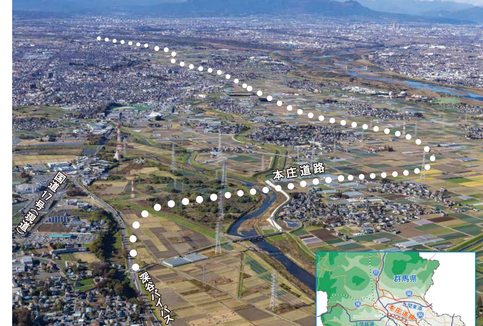
起点側より群馬県方面を望む
