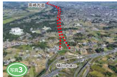
II期起点付近(桶川北本IC) 令和6年12月撮影
