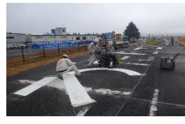
路面標示施工技能士、まさに職人技 原工業(株) 石村 毅
