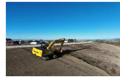
澄みきった青空の下での法面整形 河本工業(株) 村田 僚
