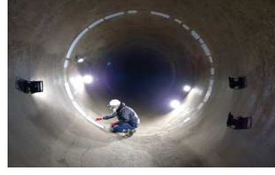
塗り残しがないよう、周囲を明るくし、丁寧に塗っています。 金杉建設(株)長谷川 海里
