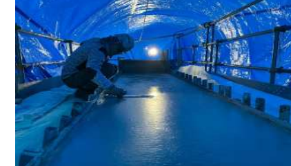
厳冬のコンクリート仕上げ ~ミリ単位の平滑さを求めて~ 小島土建(株) 藤宮 聖人
