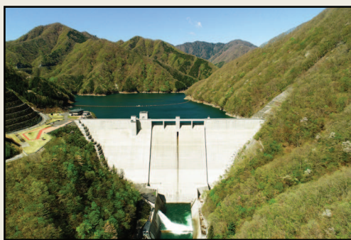
▲湯西川ダム（平成24年完成）
