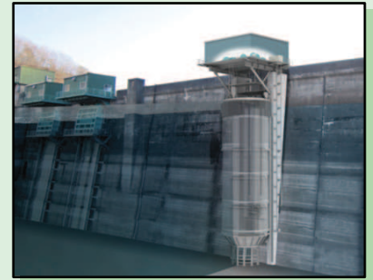
▲五十里ダム選択取水設備
