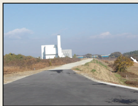
▲暫定堤防の状況（筑西市下川島地区）
