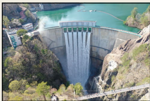
▲川俣ダム（昭和41年完成）
