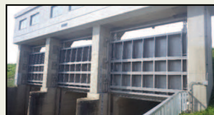
▲設備の更新（上妻排水樋管）
