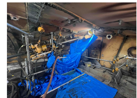
写真④：先受け鋼管の打設状況
