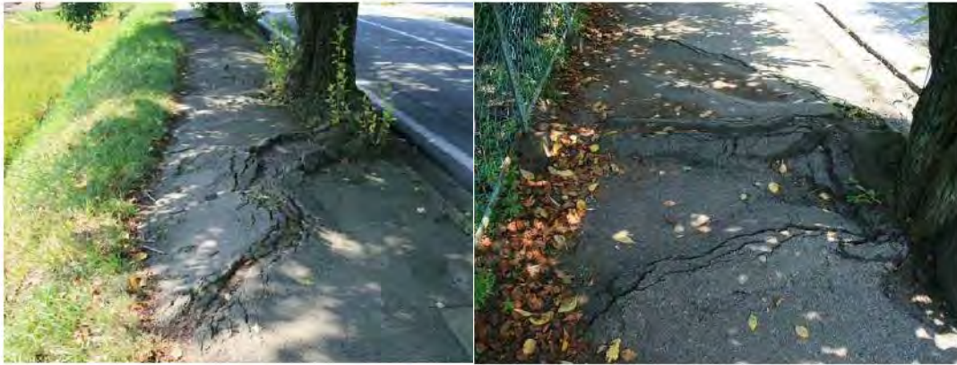
写真 舗装部の根上がり 8)
