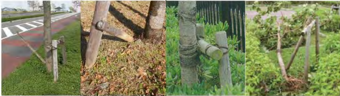
写真 支柱の損傷 3)
