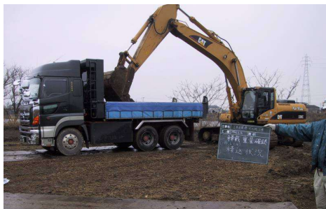
掘削土の積込・運搬
