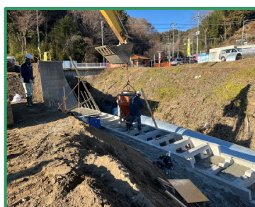
護岸（ブロック積）のための床掘作業を行っています
