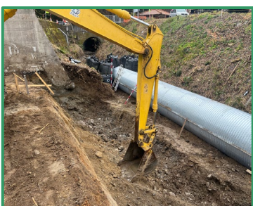
護岸（ブロック積）のための床掘作業を行っています
