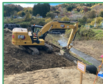
護岸（ブロック積）のための法面作業を行っています
