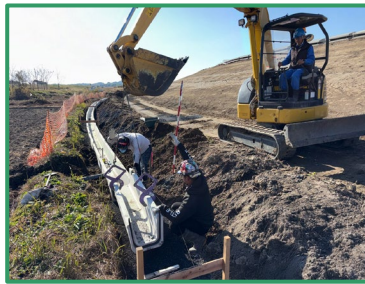
堤脚水路の設置を行っています
