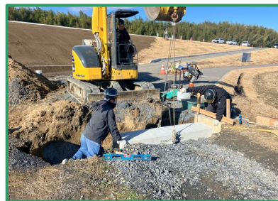
暗渠の布設作業を行っています
