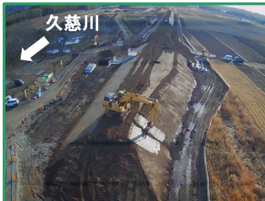
築堤盛土の全景（上空から）
