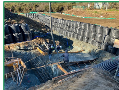
樋管の整備を行っています
