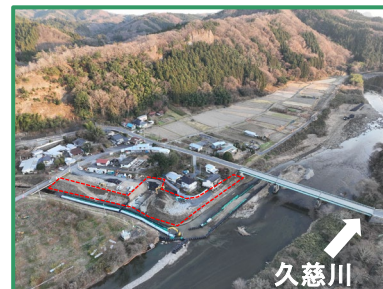
工事箇所の全景（上流から）
