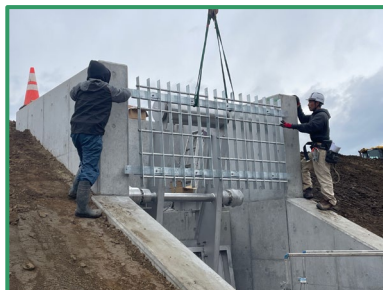
樋管の整備を行っています
