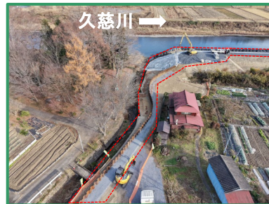
工事箇所の全景（関沢川上流から）
