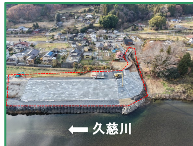
工事箇所の全景（関沢川下流から）
