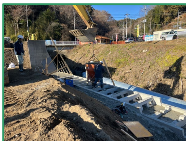
護岸（ブロック積）の整備を行っています
