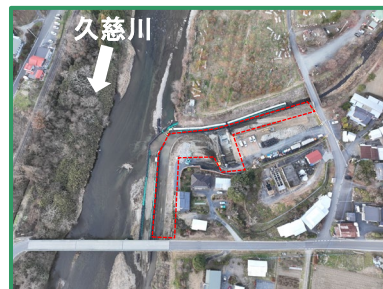
工事箇所の全景（下流から）
