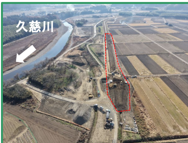
工事箇所の全景（下流から）
