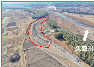
工事箇所の全景（上流から）
