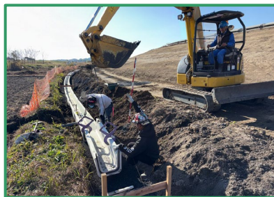
堤脚水路の設置を行っています
