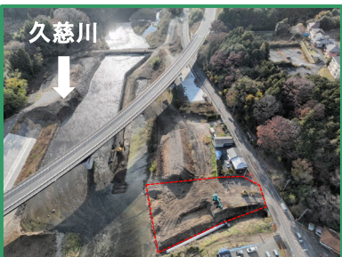
工事箇所の全景（下流から）
