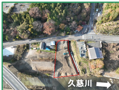
工事箇所の全景（川側から）
