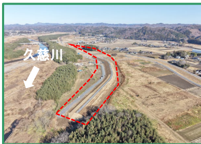
工事箇所の全景（下流から）
