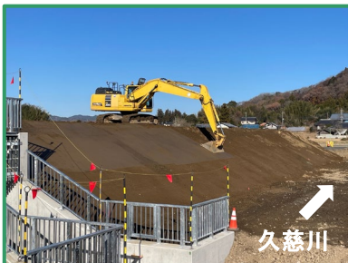
築堤盛土を行っています
