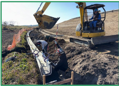
堤脚水路の設置を行っています
