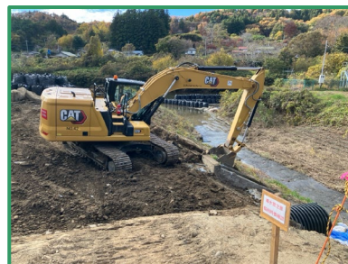
護岸（ブロック積）のための法面作業を行っています
