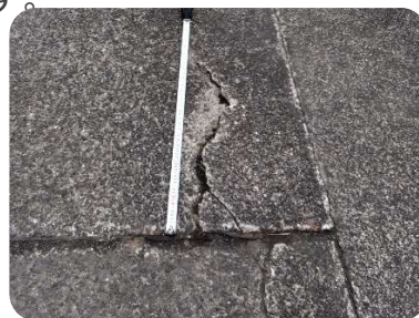
護岸の損傷 (国土交通省撮影)
