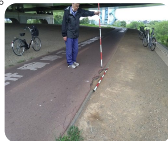
舗装の破損を確認 (国土交通省撮影)
