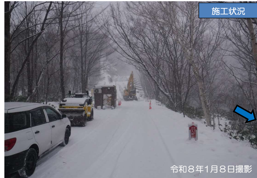
仮設道路施工中 除雪後土砂搬入
