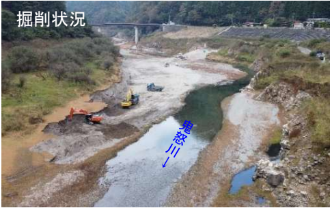
川治ダムにおける堆砂掘削状況
