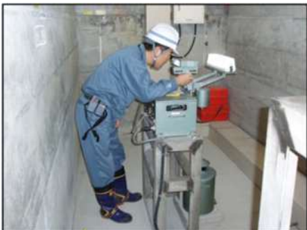
ダム堤体変位計測
