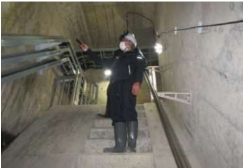
ダム堤体巡視
