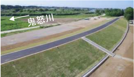
H27.9決壊箇所付近の築堤状況
