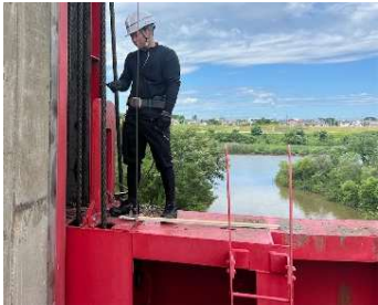
水門の施設点検
