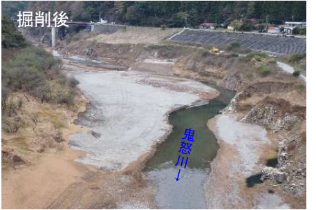
川治ダムにおける堆砂掘削状況
