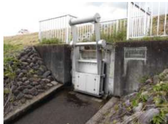
既存施設を改良して無動力化した樋管
