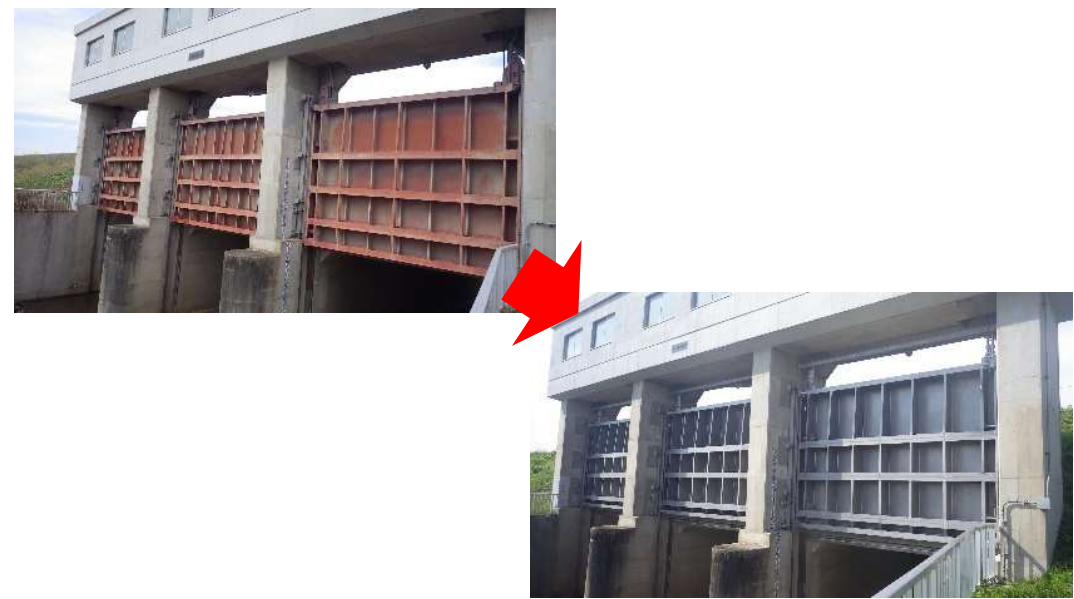
扉体の更新に合わせてステンレス化を行った事例
