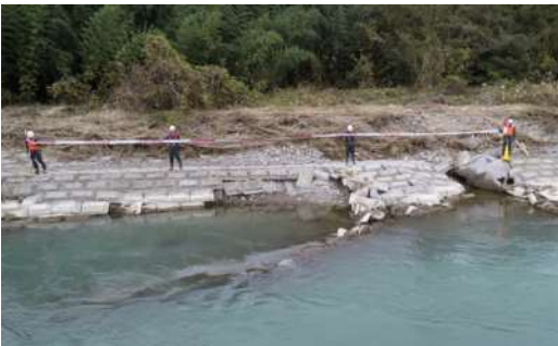
令和元年東日本台風での護岸被災状況
