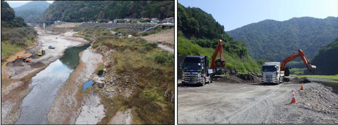
川治ダムにおける堆砂掘削状況
