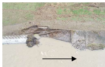
秋山川の護岸被災状況(佐野市)
