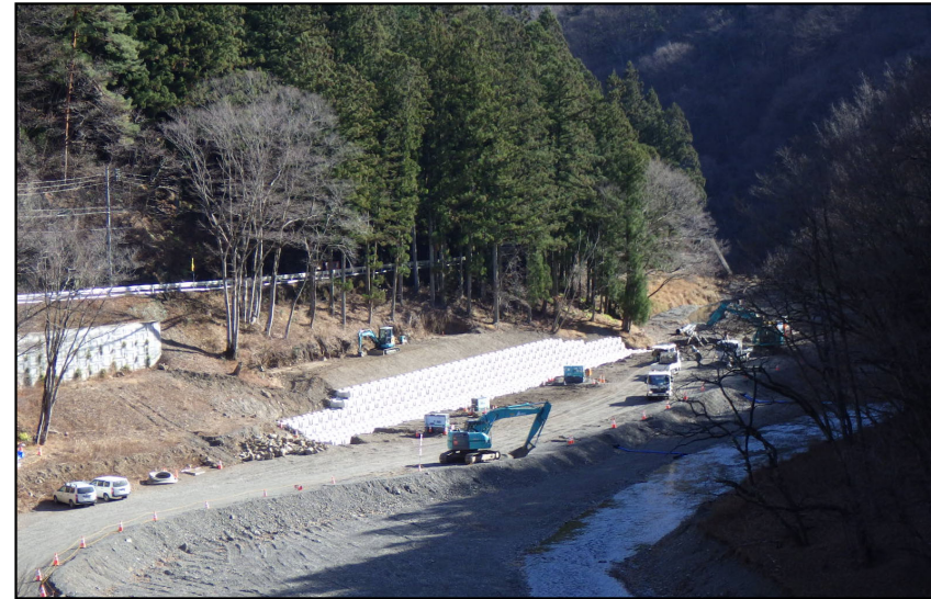
根固めブロック設置完了 遠景（乙母地区）
