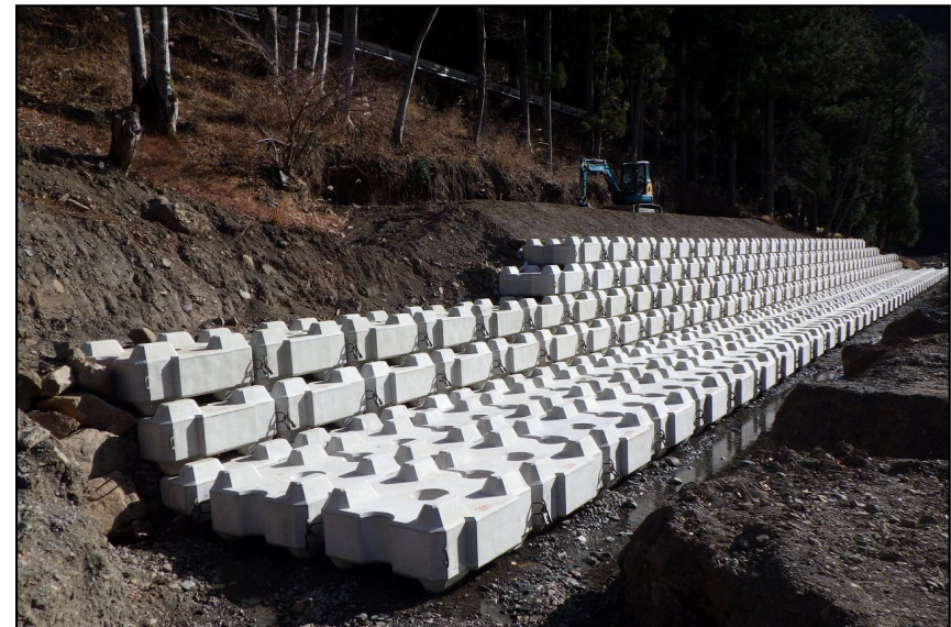
根固めブロック設置完了（乙母地区）
