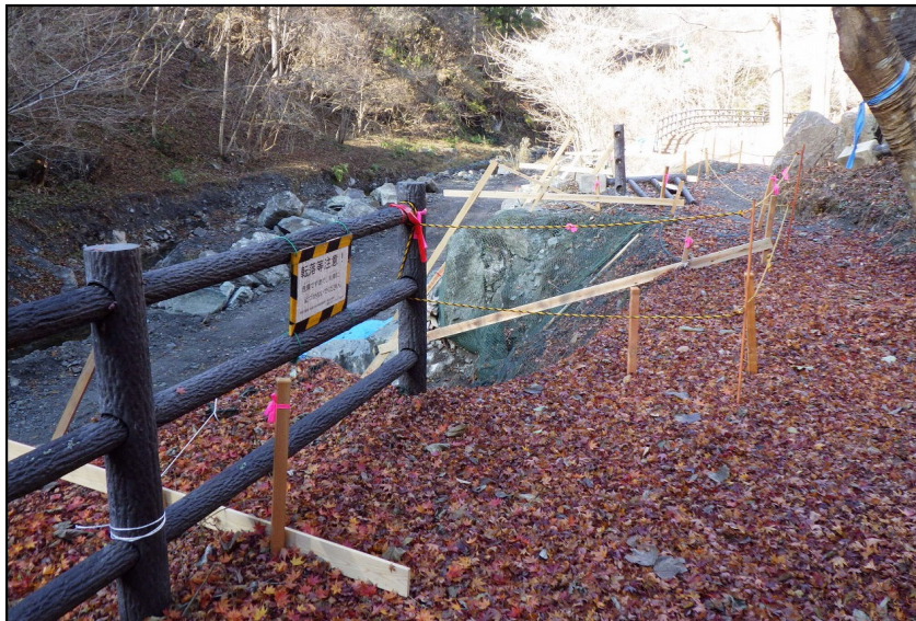
巨石張り施工状況（野栗沢護岸補修）
