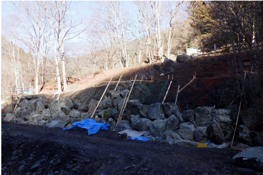
巨石張り施工状況（野栗沢護岸補修）
