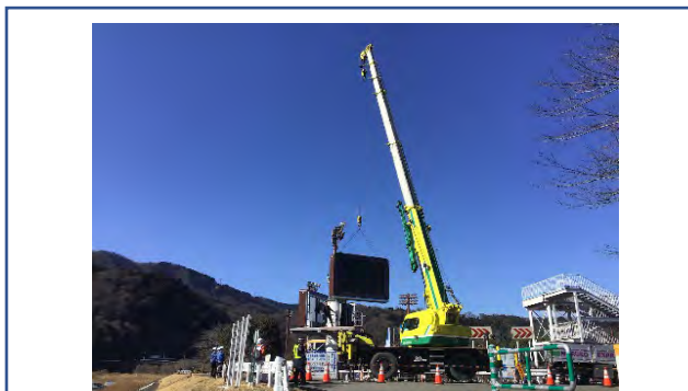
放流警報表示設備設置施工状況
