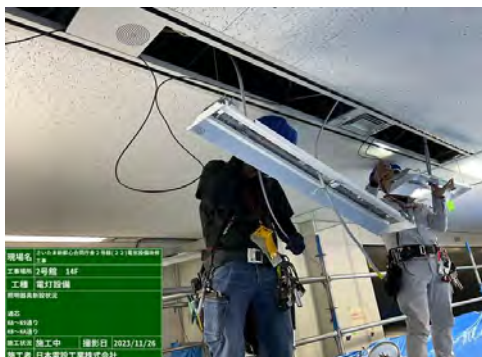
執務室照明器具取付施工状況
