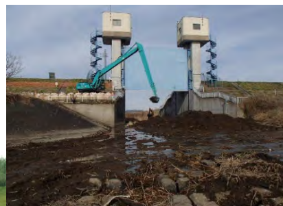
堆積土砂撤去（出流川水門）
