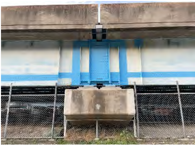
桁連結工 完成
