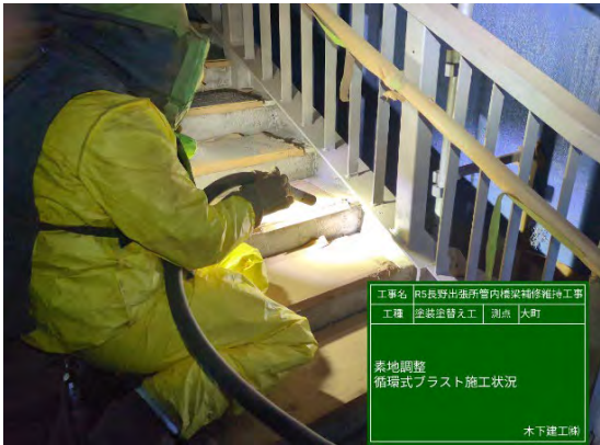
巡回式ブラスト施工状況
