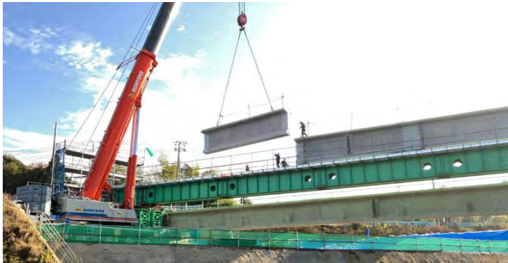
セグメント桁施工状況
