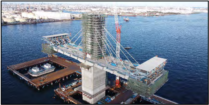
ピロン柱併用張り出し施工状況
