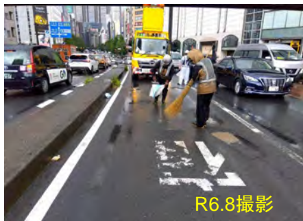
応急処理(ポットホール)対応状況
