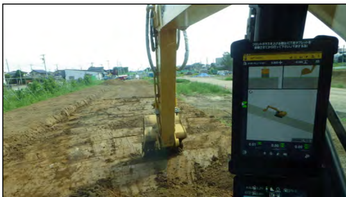
道路土工のICT施工状況
