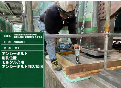
支承取替工 施工中
