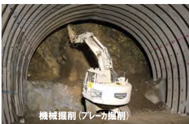
機械掘削（自由断面掘削機）
