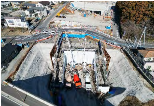
函渠頂版打設施工状況
