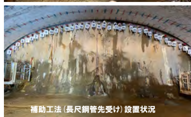
補助工法（長尺鋼管ルット、吹付Co）設置状況
