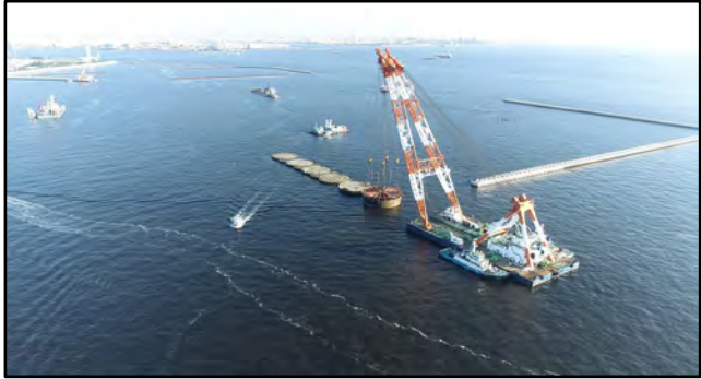
セル据付施工状況
