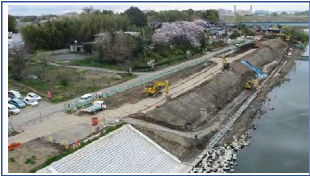
矢板護岸工施工状況
