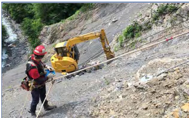
法面整形工施工状況
