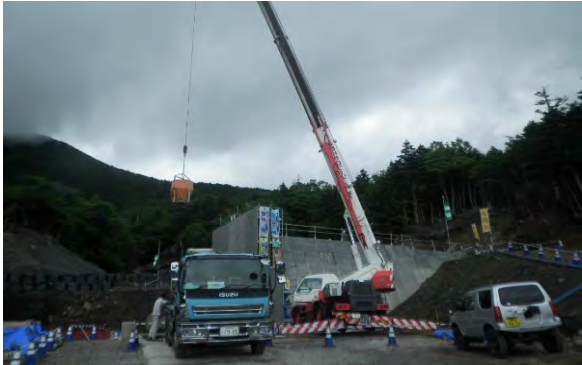
コンクリート打設状況
