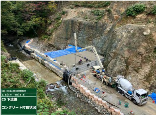
砂防堰堤コンクリート打設施工状況
