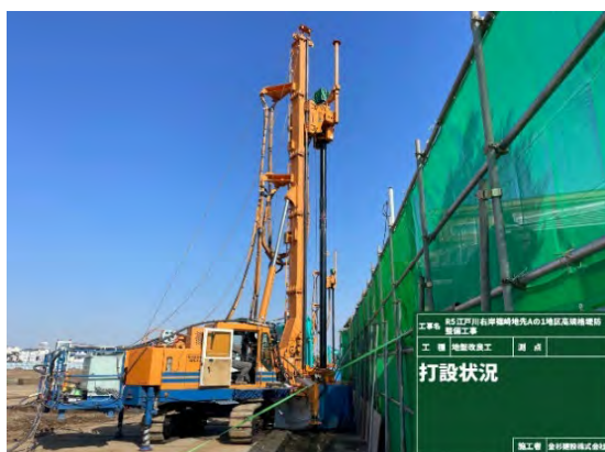
地盤改良施工状況
