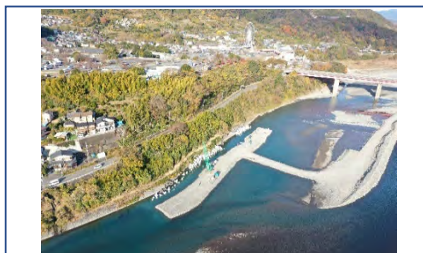
根固めブロック工施工状況
