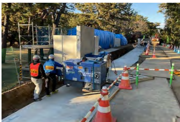
プレキャスト擁壁 施工状況
