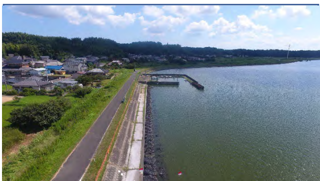
完成（梶山地先の袋詰根固め設置工事）
