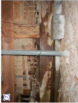
外部からの雨水侵入 土台・柱脚の雨染み
