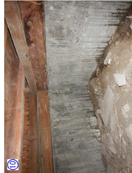
⑩ 外部からの雨水侵入。土台の下部腐朽
