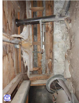
①⑥ 土台・大引の腐朽
