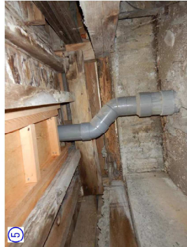
⑤ 根太・床板の腐朽(大)
