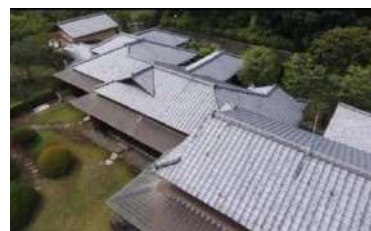
写真23 高さの異なる屋根を組み合わせた複雑な屋根構成(2019年撮影)
