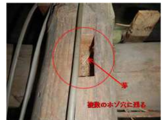
写真18 ほぞ穴内部に残る茅葺屋根の茅材破片（2019年撮影）
