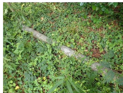
コンクリート照明柱 (劣化や意匠性から池田邸の時代に利用されていたものと推定)
