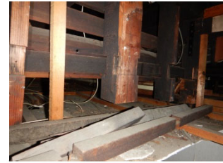
写真 48 間仕切り改造による柱切断（2019 年撮影）
