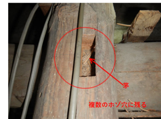
写真64 ほぞ穴内部に残る茅材破片 (2019年撮影)
