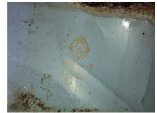
写真 53 後補屋根材 JIS (2019 年撮影)
