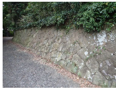
入口付近の擁壁(大磯石) (高麗山で産出された石を使った擁壁である可能性があるが、詳細は不明)
