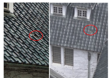
写真 59 一部落下した屋根瓦 (2019 年撮影)
