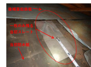
写真 52 北側屋根に残るスレート材（2019 年撮影）
