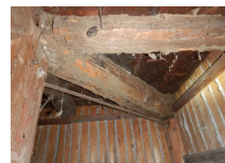
写真66 緊結鉄筋棒 (2019年撮影)
