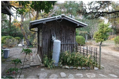
写真1 附属屋 (R1年12月撮影)
