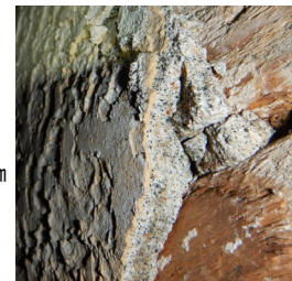
黄色系のモルタルに後補白ペンキが施される外壁
