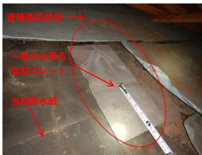
北側屋根に残るスレート材
