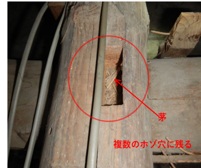
小屋梁天端ホゾ穴内部に残る茅材破片
