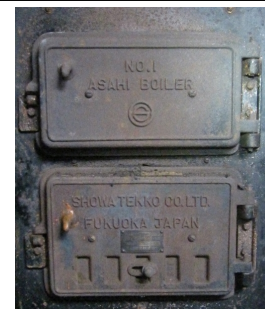
給湯用ボイラー（昭和30年製造）
