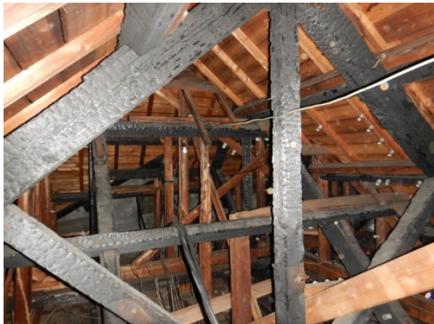
小屋裏状況：炭化が激しく補強材が入る（2019年撮影）
