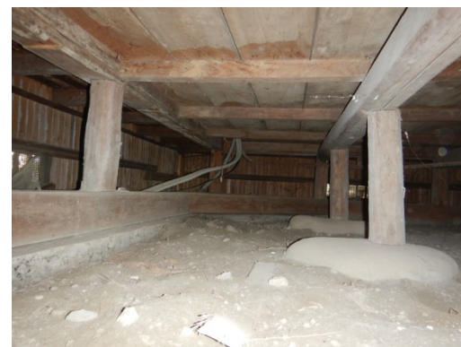
神代の間床下:写真左コンクリート製布基礎が廻る (2019年撮影)
