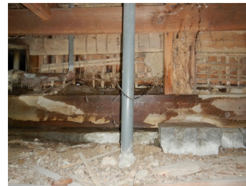
流し場：柱脚の腐朽(2019年撮影)
