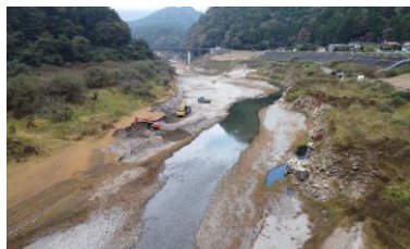
川治ダムにおける堆積土砂の掘削
