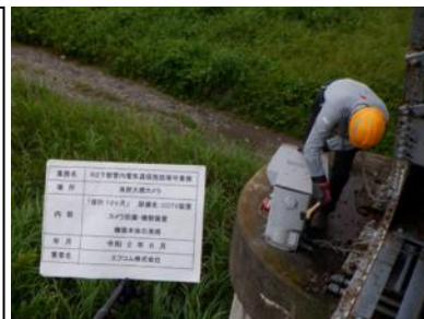
CCTVカメラの点検状況
