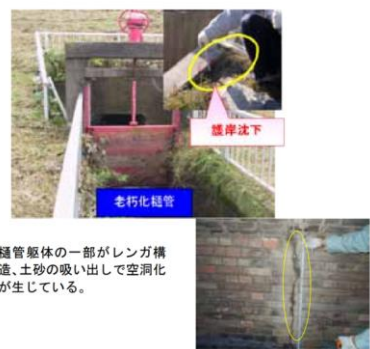
樋管の損傷状況の確認
