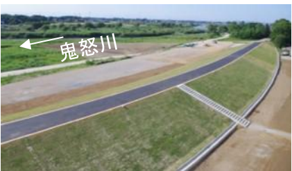
H27.9決壊箇所付近の築堤状況
