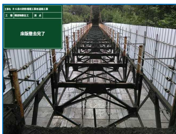
写真-10 設置完了(既設床版撤去後)
