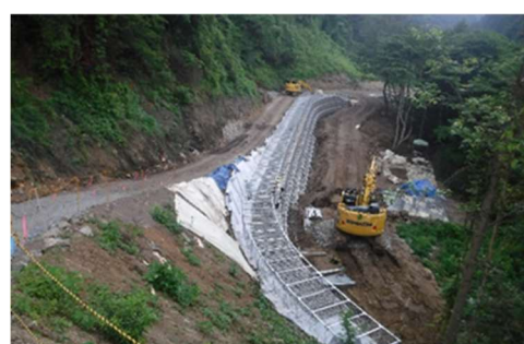
R 6 花園砂防堰堤群工事用道路工事 大型かご枠施工状況
