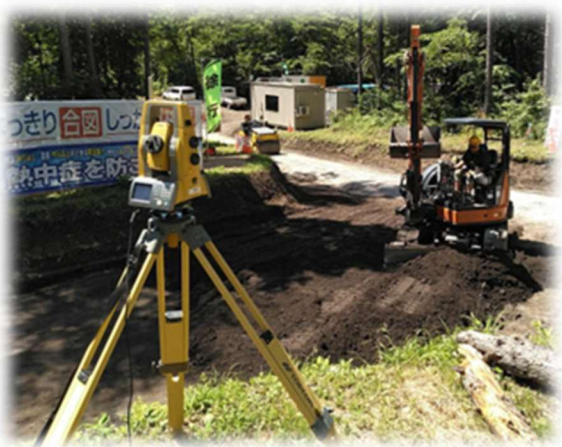
【舗装工 トータルステーションによるMG】
