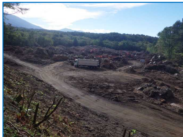
写真－6 伐木除根施工状況 9月末
