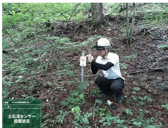
土石流センサー設置状況
