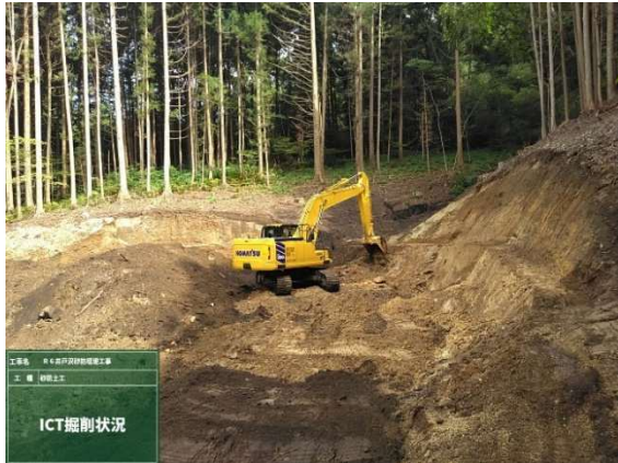
ICT 建機掘削状況
