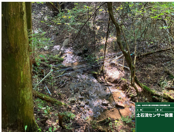
ワイヤーセンサー設置状況
