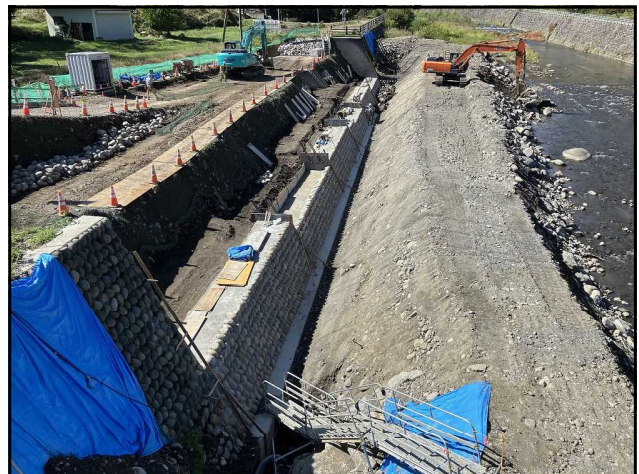
【写真2 大前吾妻川 流路護岸工施工中】
