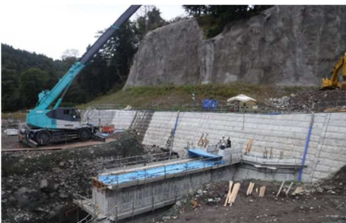
R 6 大笹床固群工事 垂直壁施工状況
