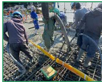
コンクリートの打設作業を行っています
