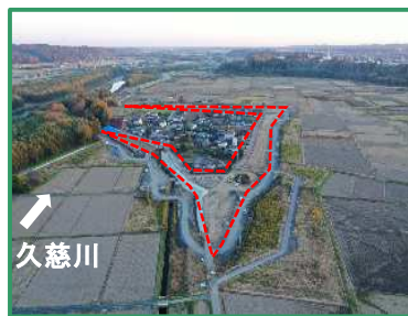
工事箇所の全景（上流から）
