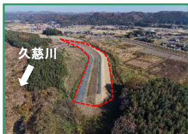
工事箇所の全景（下流から）
