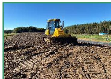
堤防盛土の工事を行っています
