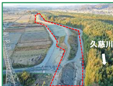
工事箇所の全景（下流から）
