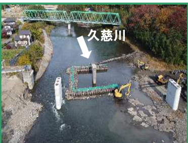
工事箇所の全景（下流から）
