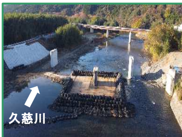
工事箇所の全景（上流から）
