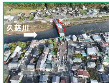
工事箇所の全景（右岸から）
