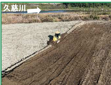
押土により土砂の集積を行っています
