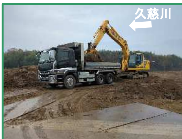
掘削土の積み込みを行っています
