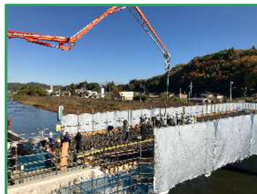
コンクリートの打設作業を行っています
