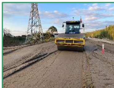
築堤のための転圧作業を行っています
