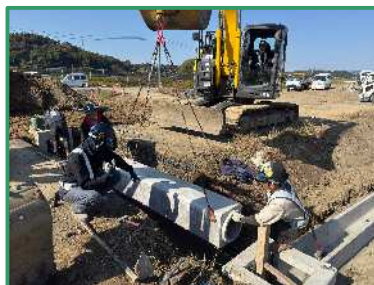
暗渠の布設作業を行っています
