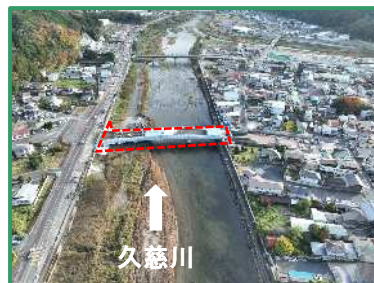
工事箇所の全景（上流から）
