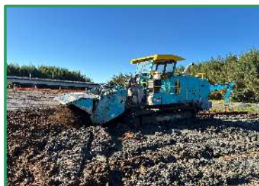
築堤材に使用する土砂を改良をしています
