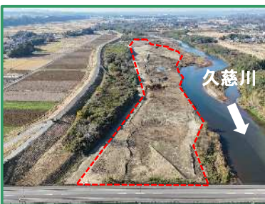
工事箇所の全景（下流から）
