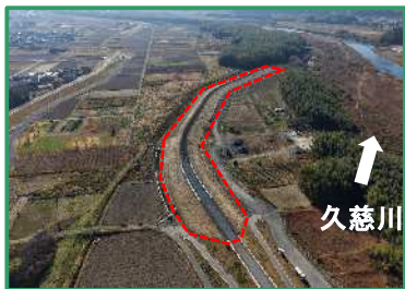
工事箇所の全景（上流から）
