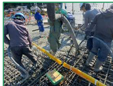
コンクリートの打設作業を行っています
