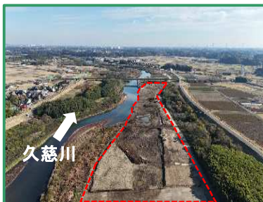
工事箇所の全景（上流から）
