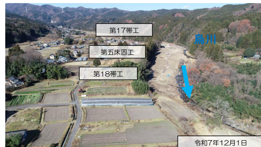
床固工 下流側から
