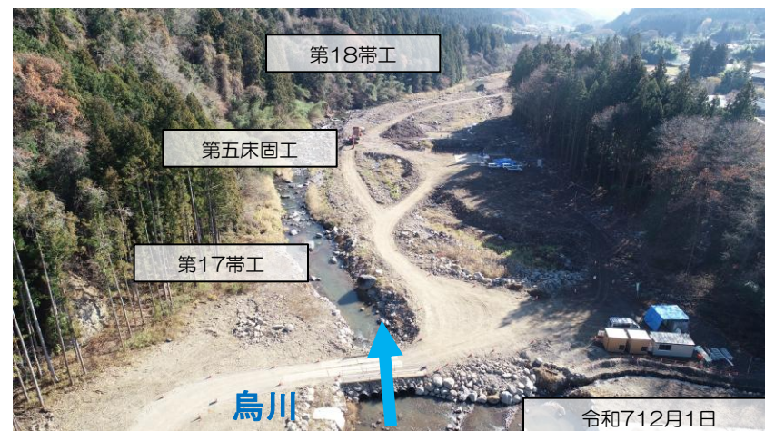
床固工 上流側から
