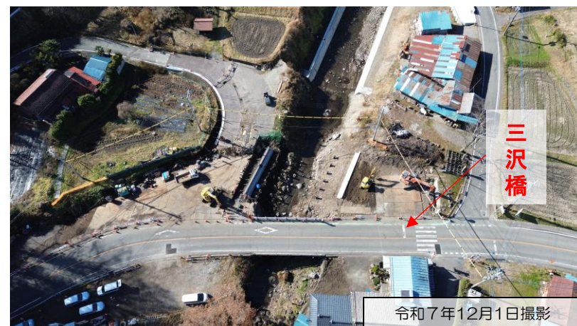
付替道路工 施工状況
