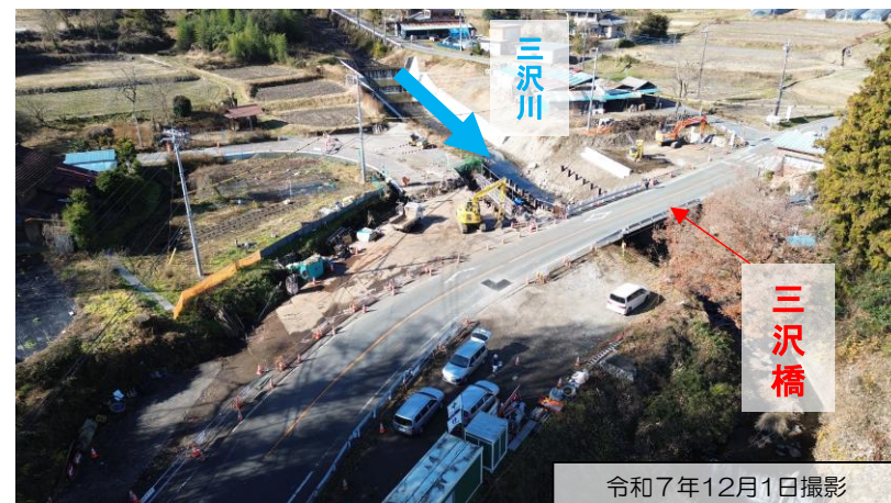
三沢橋を上空から
