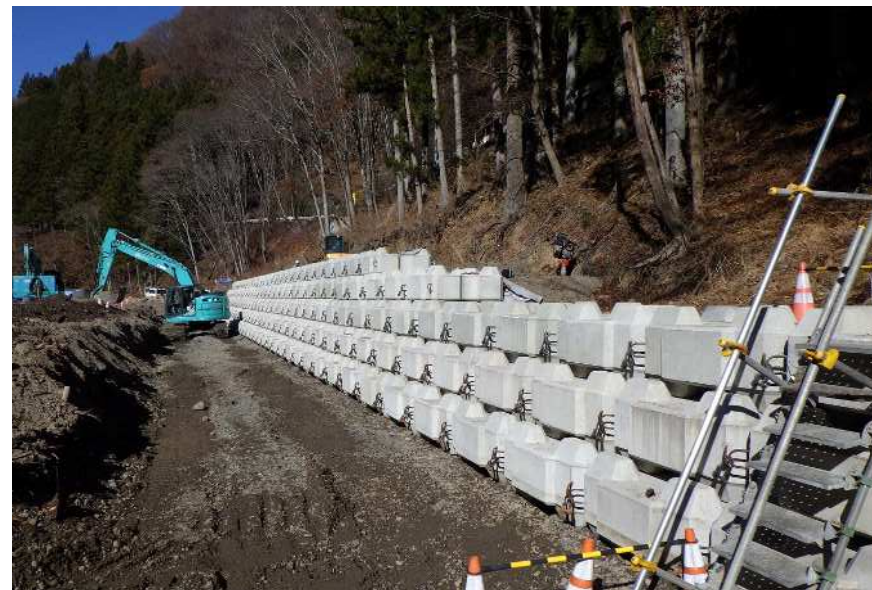
根固めブロック施工中（乙母地区）
