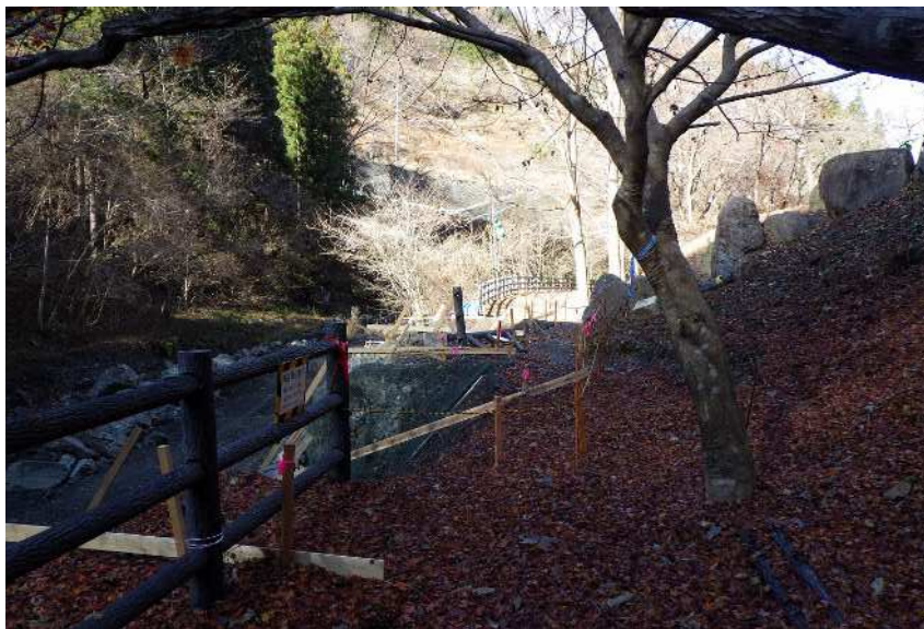
巨石張り施工状況（野栗沢護岸補修）
