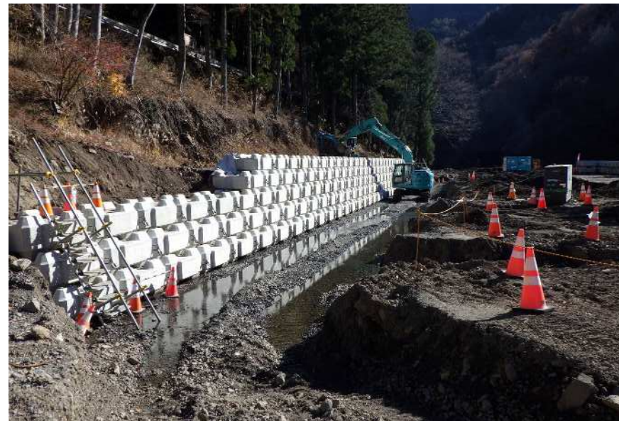
根固めブロック施工中（乙母地区）
