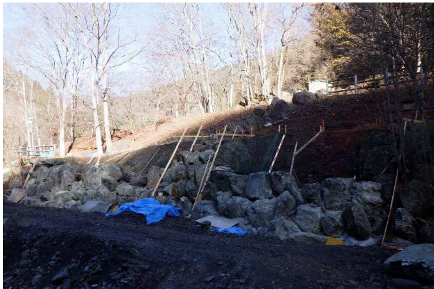
巨石張り施工状況（野栗沢護岸補修）
