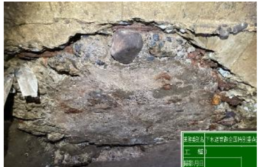
管の破損・クラックから緊急度Ⅰと判定
