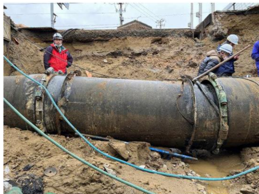
送水管の被害（七尾市）
