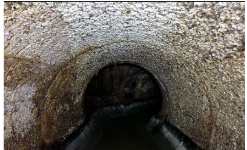
管の腐食から緊急度Ⅰと判定
