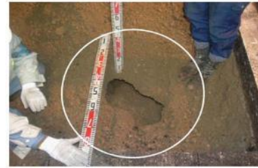
路面下空洞調査により発見された事例
