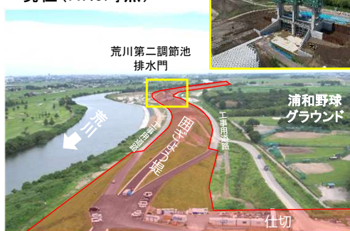
写真① 荒川第二調節池 囲ぎよう堤盛土及び荒川第二調節池排水門施工中
