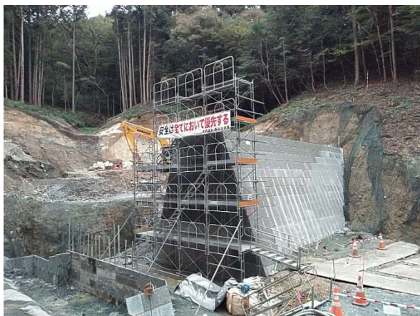
手すり先行型枠組足場設置状況
