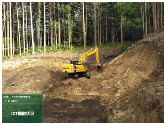
ICT 建機掘削状況
