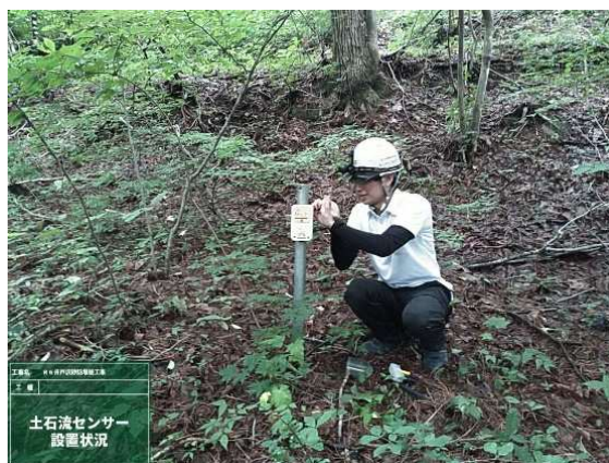
土石流センサー設置状況
