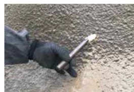
打ち込み棒で挿入
