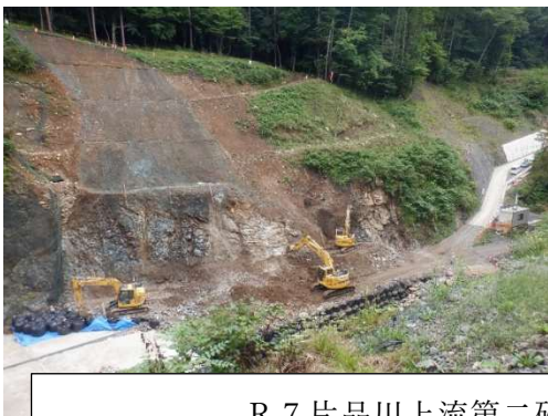
R 7 片品川上流第二砂防堰堤工事 掘削状況
