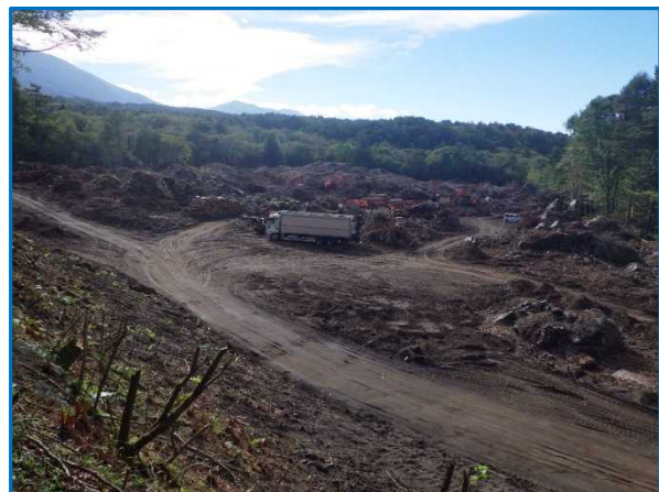
写真－6 伐木除根施工状況 9月末
