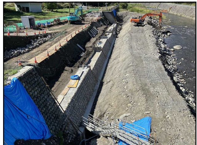
【写真2 大前吾妻川 流路護岸工施工中】
