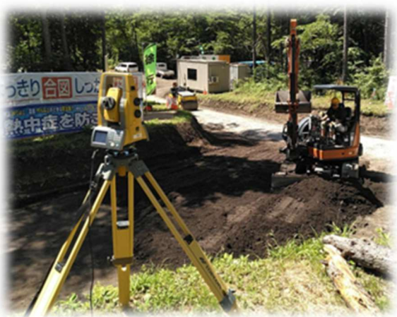
【舗装工 トータルステーションによるMG】
