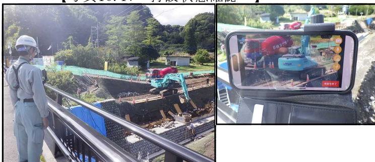
【写真16.17 打設状態確認】
