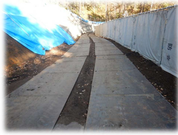
【敷き鉄板 滑り止め加工】
