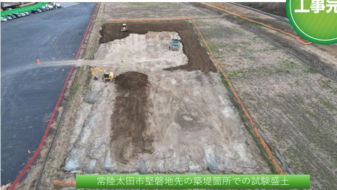
常陸太田市堅磐地先の築堤箇所での試験盛土
