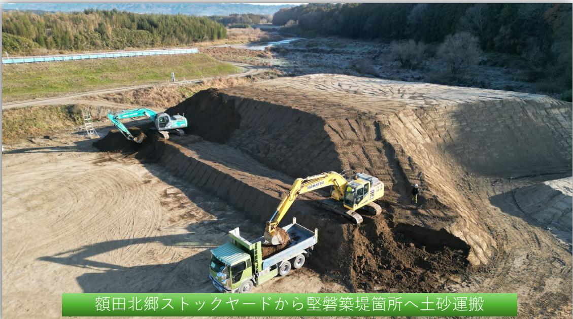
額田北郷ストックヤードから堅磐築堤箇所へ土砂運搬
