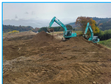
築堤盛土 （下流工区）
