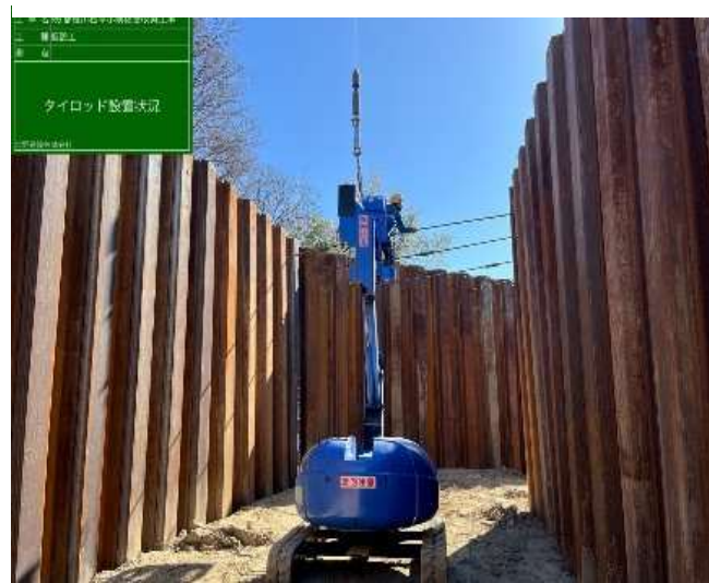
仮締切内タイロッド施工
