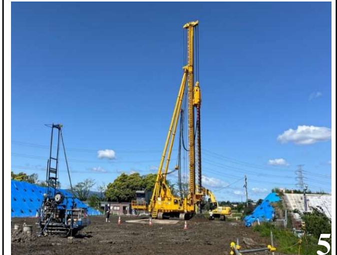
地盤改良（深層混合処理）
