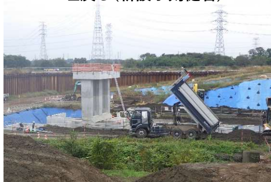
<埋戻し(新設小剣樋管)>
