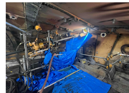
写真④：先受け鋼管の打設状況
