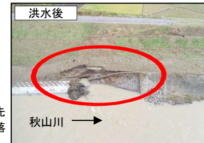
秋山川 伊保内町地先 低水護岸崩落
