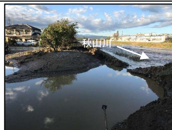
秋山川右岸の堤防決壊状況(佐野市)
