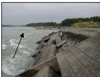
渡良瀬川の護岸被災状況(太田市)
