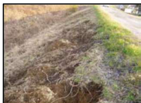
イノシシによる 法面破損
