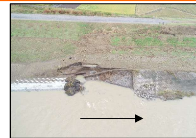
支川秋山川の護岸被災状況(佐野市)
