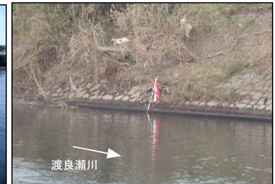
低水護岸崩落状況
