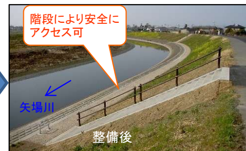
階段整備や緩傾斜堤防の整備による河川へのアクセス改善
