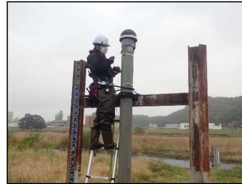
水位観測施設の点検・補修
