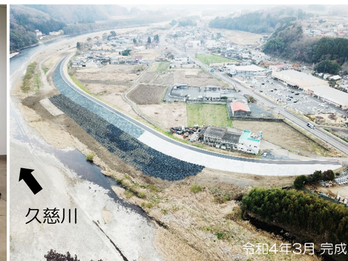
-工事完成状況-
