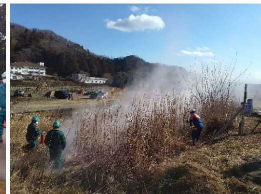
-現場付近火災の初期消火状況- (㈱秋山工務店より写真提供)
