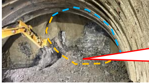
崩落した土砂の状況
