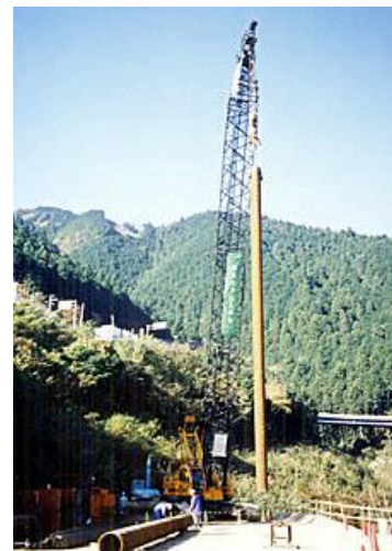
鋼管杭施工事例
