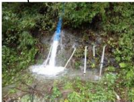
横ボーリング工DY-1及び 集水井工の排水状況
