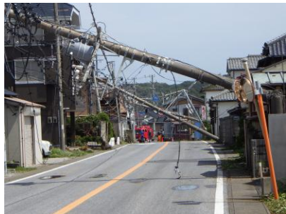
令和元年台風15号による電柱倒壊状況
