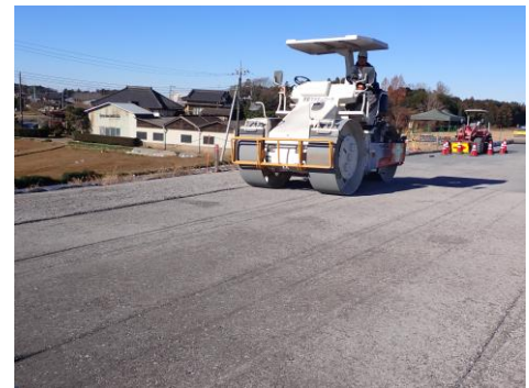
鉄鋼スラグ路盤工
