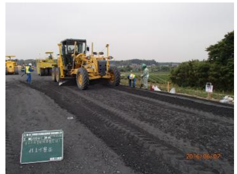
セメント安定処理路盤工
