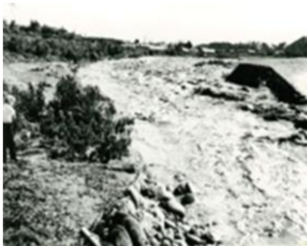
写真 1 昭和 34 年（1959 年）笛吹川左岸決壊（山梨県 市）
