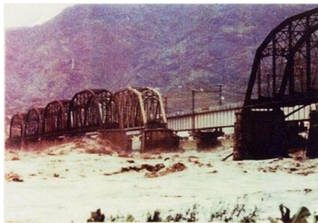
4 写真 3 昭和 57 年（1982 年） 富士川 JR 富士川鉄橋の落橋（静岡県富士市）
