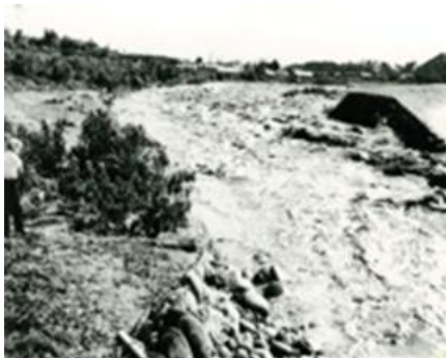
写真 1 昭和 34 年（1959 年）笛吹川左岸決壊（山梨県 市）
