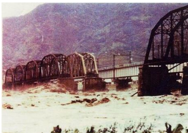
写真 3 昭和 57 年（1982 年） 富士川 JR 富士川鉄橋の落橋（静岡県富士市）
