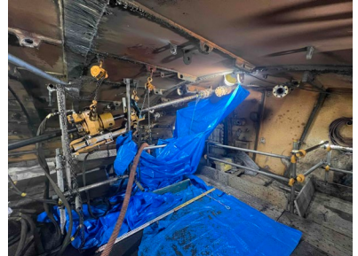
写真④：先受け鋼管の打設状況
