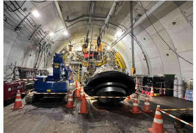
写真③：1次解体状況
